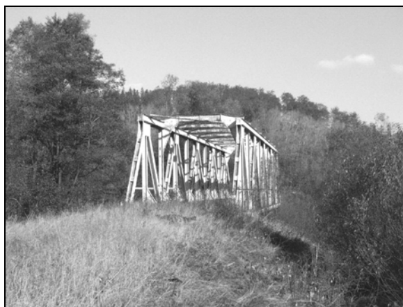
Fot. 1. Wiadukt kolejowy linii Kłodzko-Stronie Śląskie w Strachocinie.
